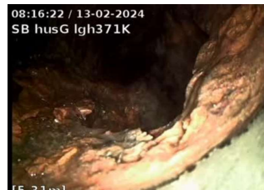
Rostangripet gjutjärnsrör
