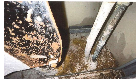
Rörschakt av ursprungligt utförande
