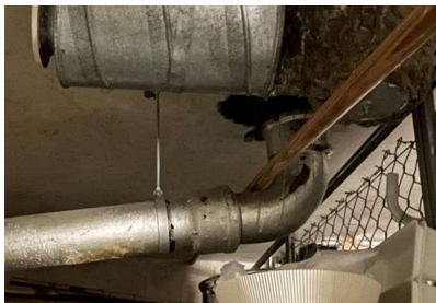
Genomrostning stamledning källare
